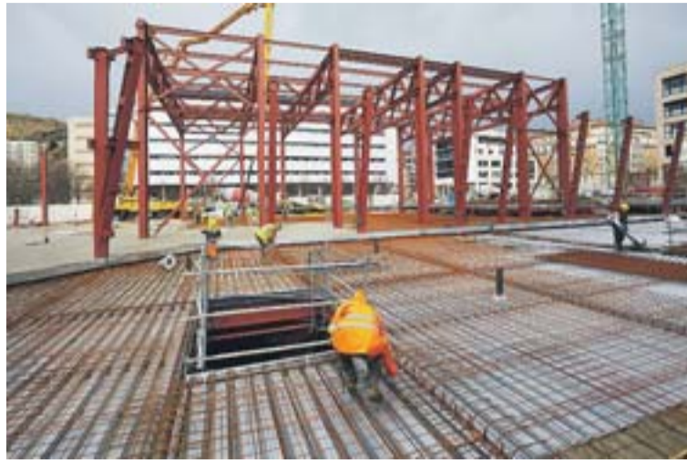
Estructura del futuro auditorio, una de las 'joyas' del centro.
