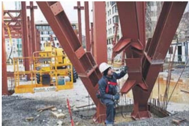
Los trabajos avanzan en el solar de Ibaeta.
